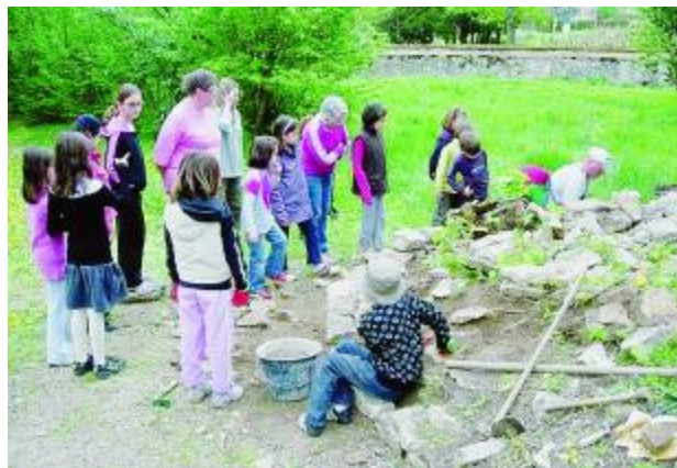
Pendant la construction du muret
